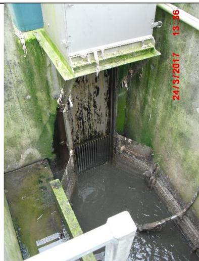
Exemple de dégrilleur capoté et fermé (source FB Procédés)
